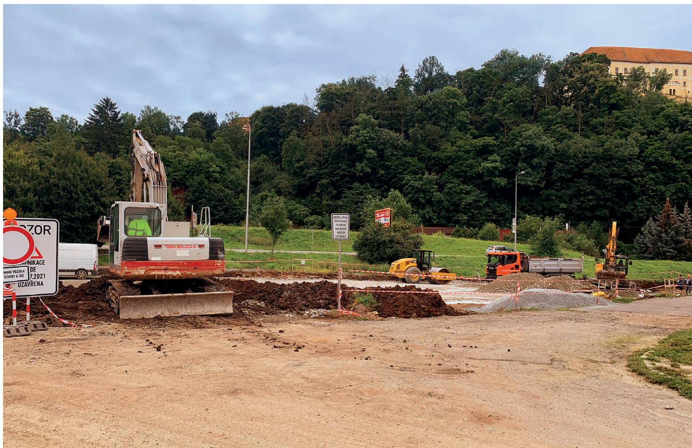
Výstavba parkoviště u hasičárny
